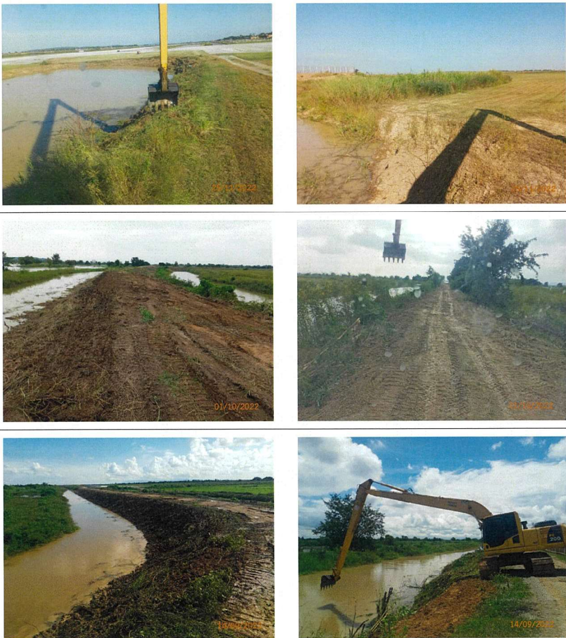
ภาพถ่ายที่ 2.2-24 การขุดลอกคูระบายน้ำ และกำจัดวัชพืช
